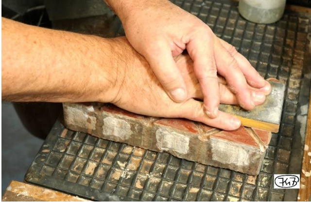
Bild 51: Abrichten des Schleifsteines auf dem Klinker
